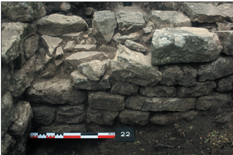
Fig. 110 : Détail du bâti du mur MR 2006, cliché vu du nord
