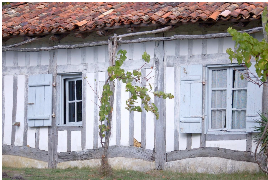
Figure 39, soubassement de la maison à colombage des Landes.
