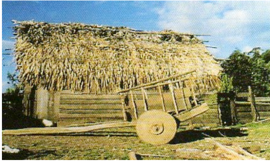
Figure 13, A gauche, la Ruca Williche, normalement de plan carre, a ses murs bardés dans le sens horizontal et son toit incliné en paille. A droite La Ruca Pewenche de plan carre est matérialisé complètement (toit et murs) en bois sous forme de canoës. Cette matérialité permet de bien supporter le poids de la neige cumulé sur la toiture pendant les périodes froides. Cette ruca correspond au territoire de montagne. Photos (Ministerio de Obras Públicas, 2003)
