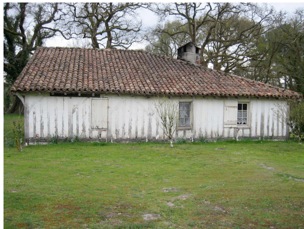
Figure 37, Airial landais, façade Nord, profile de la toiture en croupe vers l'Ouest.
