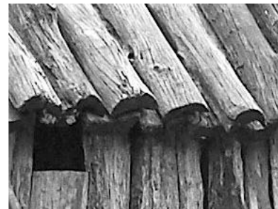
Figure 31, structure et enveloppe à base de "huencos", troncs évidés.
