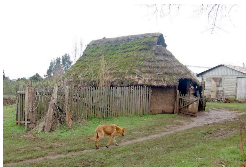
Figure 24 La porte rongée dans la toiture de la Ruca Nagche met en évidence la volonté de protection enveloppante de la toiture.
