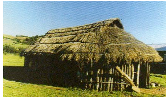
Figure 14, A gauche, la Ruca Lafkenche (côtière) de plan circulaire structuré a base de poteaux bois est constituée intégralement de paille (toiture et murs). A droite la Ruca Nagche de plan oval : structure à base de poteaux - poutres bois, toiture en paille et murs bardés avec des lames de bois verticales. Malgré ces différences dans la matérialité et dans la morphologie, l'orientation vers l'Est de la porte de la Ruca est systématique : la porte est alors orientée vers l'aube, vers les premiers rayonnements solaires du jour. Photos [Ministerio de Obras Públicas, 2003]
