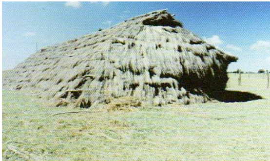
Figure 14, A gauche, la Ruca Lafkenche (côtière) de plan circulaire structuré a base de poteaux bois est constituée intégralement de paille (toiture et murs). A droite la Ruca Nagche de plan oval : structure à base de poteaux - poutres bois, toiture en paille et murs bardés avec des lames de bois verticales. Malgré ces différences dans la matérialité et dans la morphologie, l'orientation vers l'Est de la porte de la Ruca est systématique : la porte est alors orientée vers l'aube, vers les premiers rayonnements solaires du jour. Photos [Ministerio de Obras Públicas, 2003]
