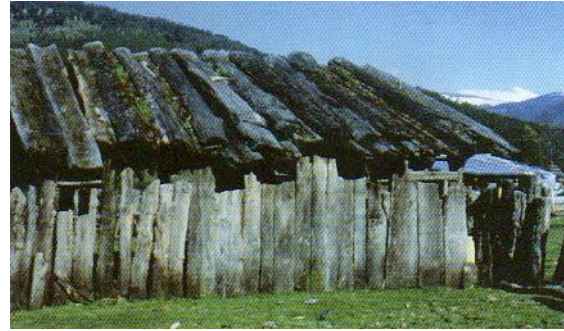
Figure 13, A gauche, la Ruca Williche, normalement de plan carre, a ses murs bardés dans le sens horizontal et son toit incliné en paille. A droite La Ruca Pewenche de plan carre est matérialisé complètement (toit et murs) en bois sous forme de canoës. Cette matérialité permet de bien supporter le poids de la neige cumulé sur la toiture pendant les périodes froides. Cette ruca correspond au territoire de montagne. Photos (Ministerio de Obras Públicas, 2003)
