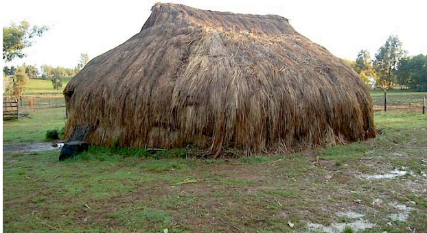
Figure 28, Le toit et les murs de la Ruca Lafquenche créent une continuité depuis le faîtage jusque au sol.
