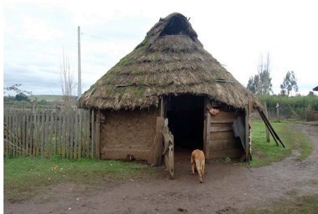
Figure 23 Ruca Nagche, proportion hauteur de toiture et hauteur des murs, 2/3 correspondent à la toiture et 1/3 correspond à la hauteur des murs.
