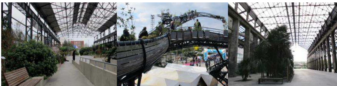
Aménagement de l'espace semi-ouvert des anciens volumes industriels
