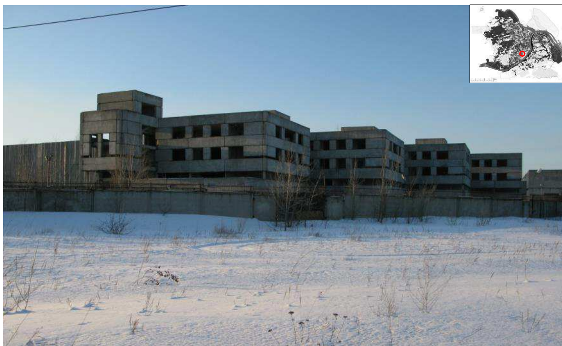
Figure V-10. Chantier non-accompli du Corpus des constructeurs de l'usine automobile. L'arrêt du chantier est lié à la chute de l'Union Soviétique en 1991. Nijni Novgorod, janvier 2011.
