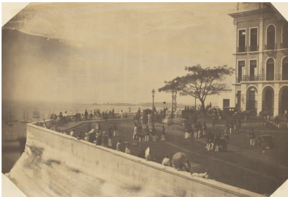
Ce ne sont ni les voiliers de la rade ni le théâtre qui retiennent ici l'attention du photographe mais bien les groupes de soldats en uniforme d'apparat qui entourent de petites pièces d'artillerie et les promeneurs endimanchés. [BNF WF 113-19]
