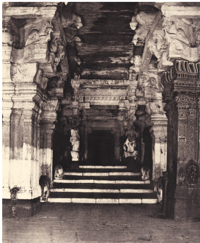
Madurai - Escalier du Muduramian mundapam [temple de Meenakshi] (WD 109-12)
