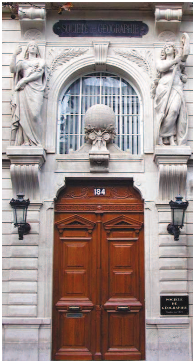
L'entrée du nouvel hôtel de la Société de Géographie. Alfred Grandidier a participé au financement des statues qui confèrent davantage de prestige au bâtiment [IM]
