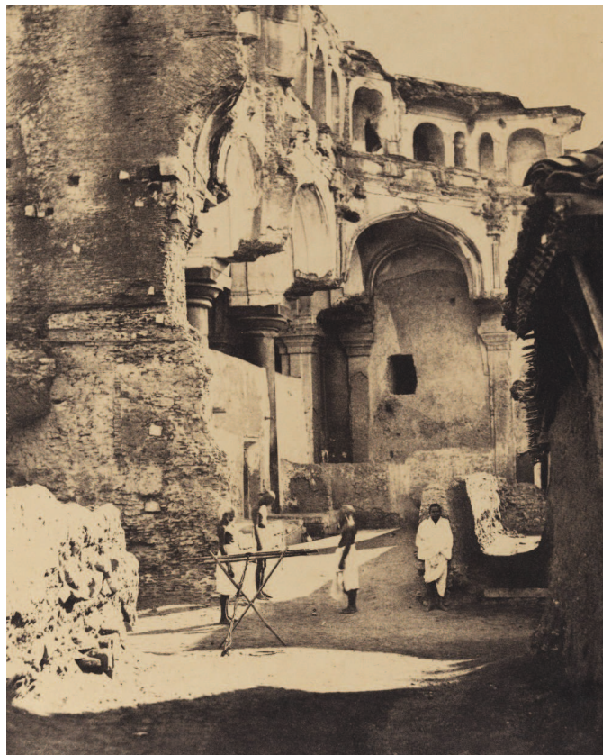
Madurai - Intérieur du palais en travaux (WD 109-22)
