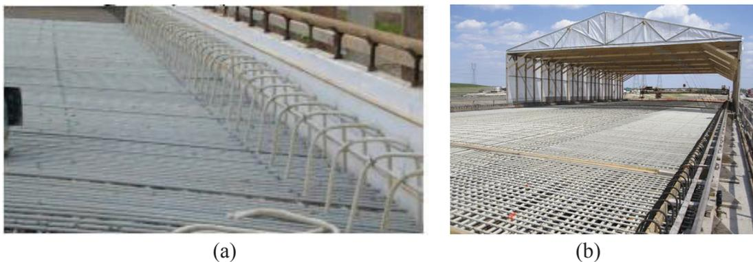
**Figure 2.13**- Utilisation de barres PRF pour (a) le pont de Wotton [El-Salakawy et al., 2002] et (b) le pont de Brandon sur la rivière Assiniboine, Manitoba au Canada [Malnati, 2011]
