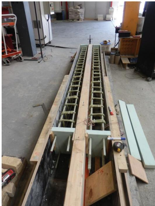
**Figure 7.13** – Coffrages des poutres de portiques prêts à être coulés
