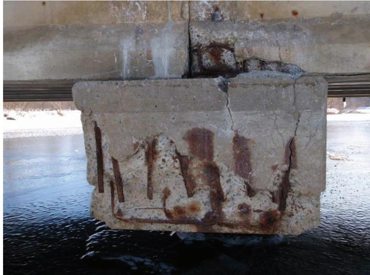
**Figure 1.2** – Corrosion des armatures d'un pilier de pont en milieu salin
