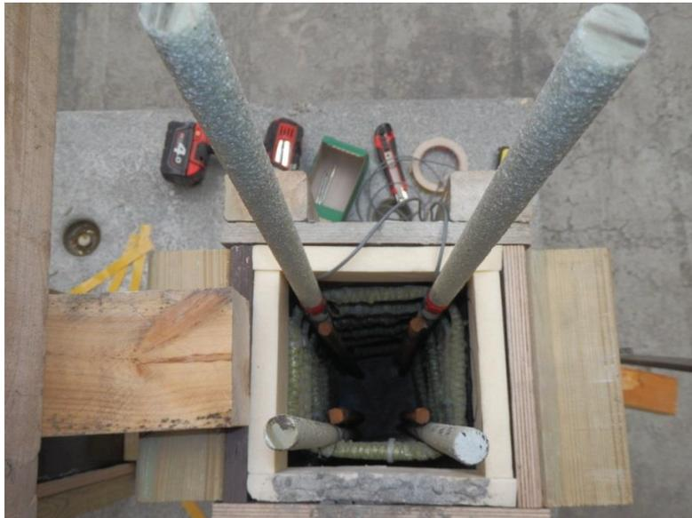
**Figure 7.12** – Mise en place des armatures dans les coffrages des poteaux
