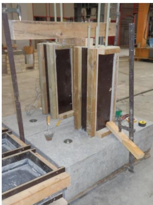
**Figure 7.11** – Coffrage des poteaux positionnés sur les fondations
