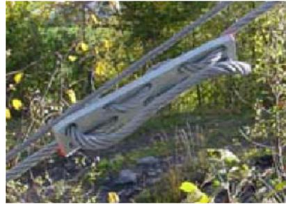
**FIGURE 2.13** – Le dissipateur d'énergie par cheminement complexe [42]
