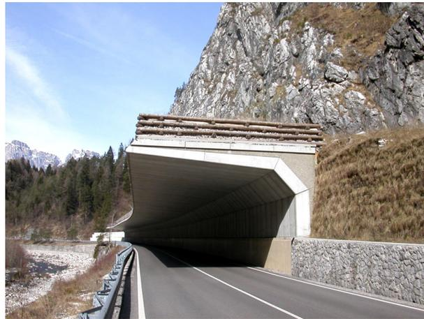
FIGURE 2.6 – Une galerie pare-blocs [Geosistema]
