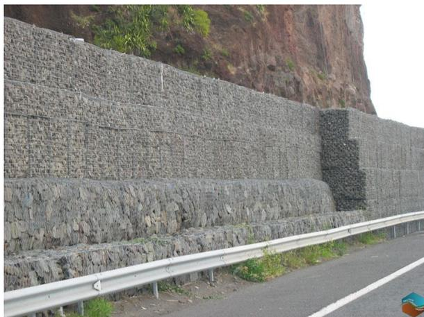
**FIGURE 2.4** – Un merlon [GABION]
