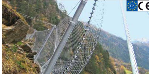
**FIGURE 2.7** – Un écran de filets pare-blocs [GEOBRUGG]
