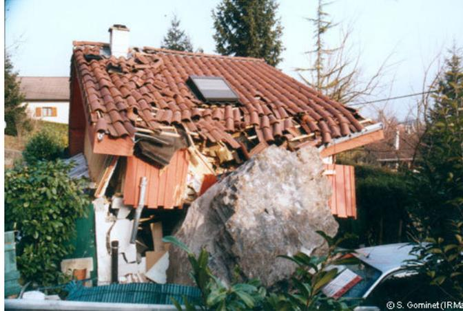
**FIGURE 1.1** – Chute de blocs depuis le versant Est du massif de la chartreuse, 2002 [IRMa]
