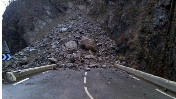
**FIGURE A.1** – Éboulement rocheux dans les Gorges de l'Arly [Radio Mont Blanc].
