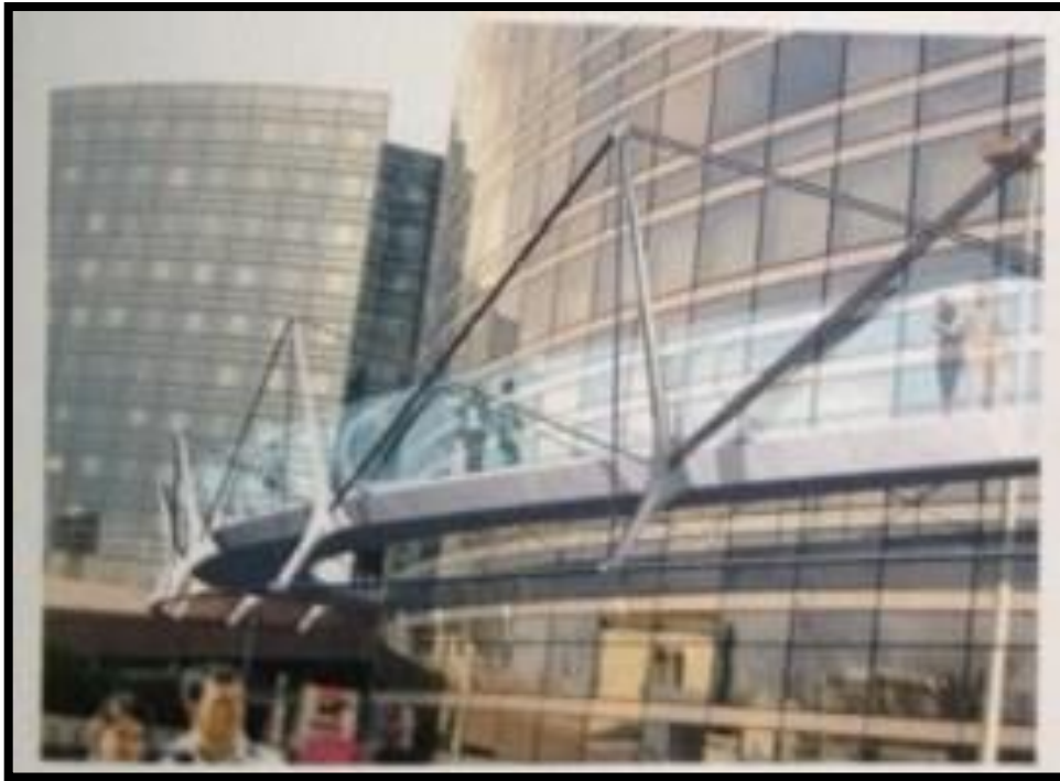
Fig.28. La passerelle extérieure (sources : http://www.archello.com/en/project/passerelle-valmy-la-d%C3%A9fense )
