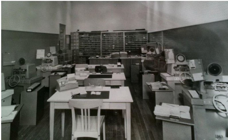
Fig.4. Salle de travail de l'Agence Centrale de la Société Générale, photo prise dans les années 1950 (archives historiques Société Générale, CAP 18).
