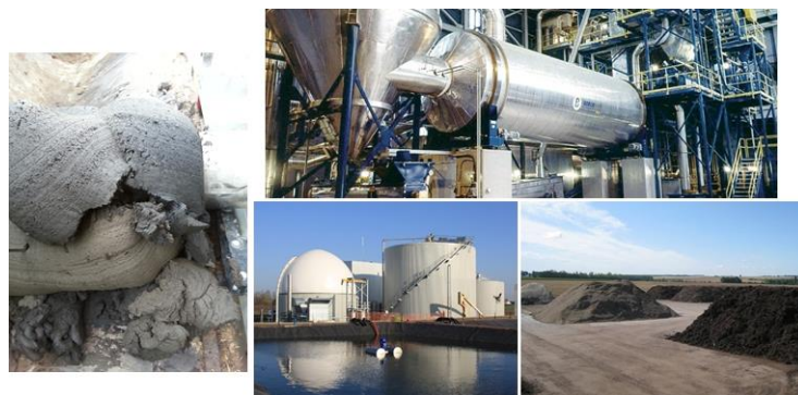
Figure 2-6 Stabilisation des boues : boues chaulées (Irstea), séchoir rotatif (Berlie-Falco), digesteur (Graincourt, Apro Industrie), aire de compostage de boues (Valterra).
