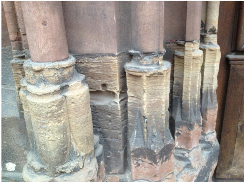
FIGURE 1.8 – Incompatibilité de deux matériaux gréseux au sein de la Cathédrale de Strasbourg (France). Le grès blanc, situé au niveau du sous-bassement, est fortement altéré contrairement au grès rose ; source : M. Denecker.
