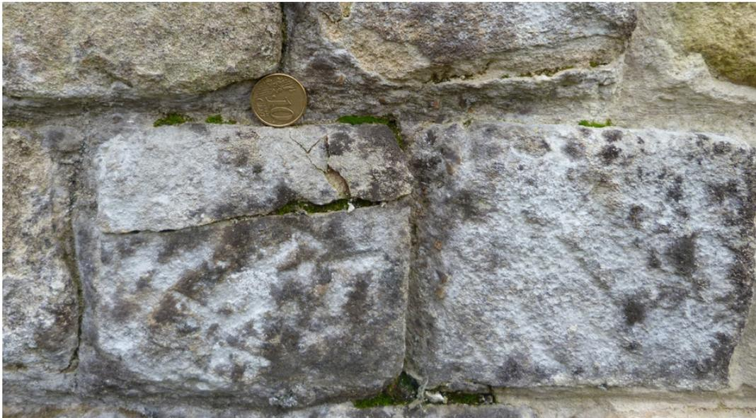
FIGURE 1.1 – Efflorescences (tâches blanchâtres pulvérulentes) sur un mur de calcaire lutétien du site archéologique Gallo-romain de Genainville (France) ; source : M. Denecker.
