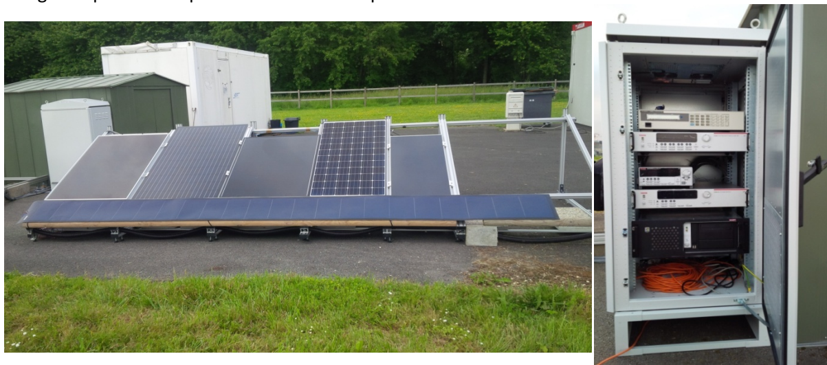
Fig.6.24. Plateforme PV1 installée au SIRTA en Avril 2014 (gauche) et son instrumentation (droite)
