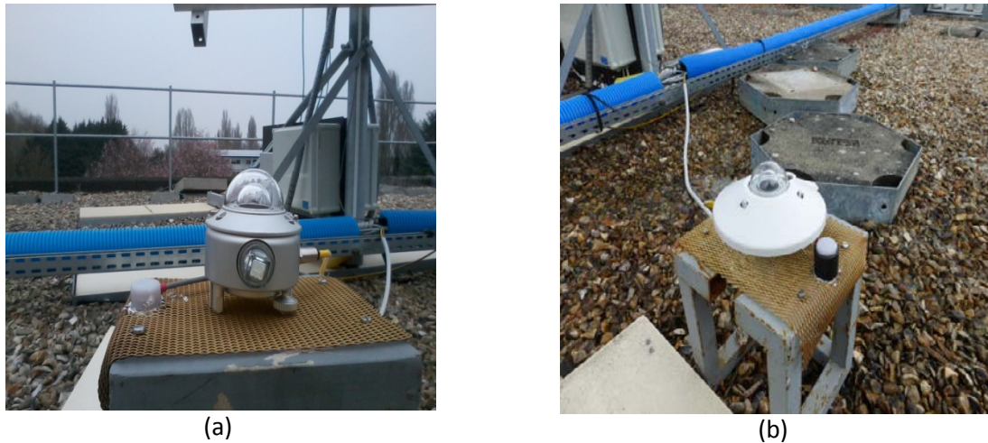
Fig.5.13. Dispositif de mesure de l'éclairement global horizontal en extérieur avec cache métallique (a) et avec cache noir (b) pour la RG100, sur le toit du LGEP
