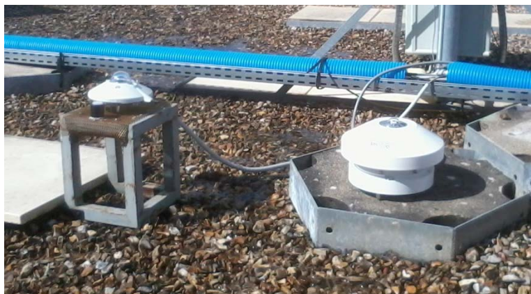
Fig.6.14. Sondes d'éclairage (gauche) et spectroradiomètre (droite) installés sur le toit du LGEP
