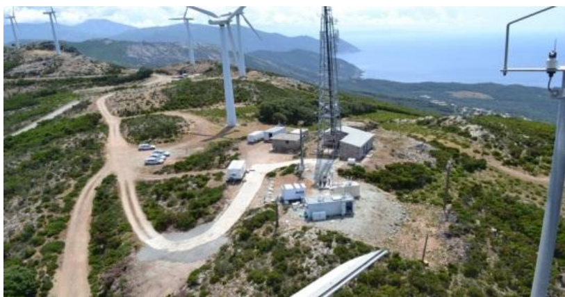
Station atmosphérique du Cap Corse, située dans la commune d'Ersa. Photographie prise depuis le sommet d'une éolienne LSCE/IPSL François Dulac
