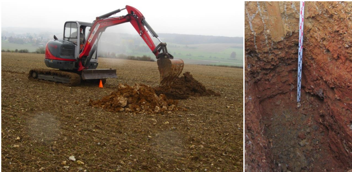
Figure 3-9 : Photos du creusement d'une fosse à la mini-pelle à l'aplomb du lac des Stalactites et de la mise en place d'une mire graduée.
