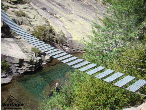
FIGURE 1.17 – Pont de singe piéton en Corse : ce type de pont est soumis aux propriétés mécaniques des câbles, et a donc une forme de chaînette. Crédits : “Passerelle de la Spasimata”, randonnée du Cirque de Bonifate, R-montagne.fr
