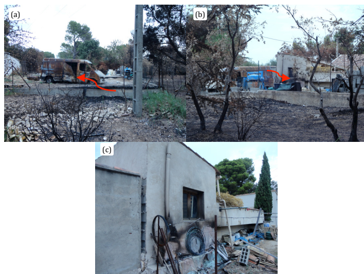
Fig. 67 : Dommages observés sur l'habitation CAV_13 : (a) un stock de bois entre en contact avec le feu, sa combustion entraîne celle du camion ; (b) l'incendie du camion impacte par rayonnement le matériel stocké au pieds de la maison et brise la vitre (c)
