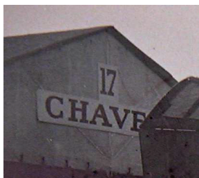
Figure 14 : Détail du cliché France-45523-Arcachon(4)
