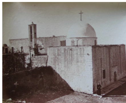
Figure 39 : Cliché intitulé "Eglise et couvent de Ghazir" (F.P. 1C5-2)
