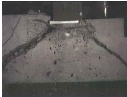
Figure 201 – Endommagement de la poutre n°3 dans l'essai.
