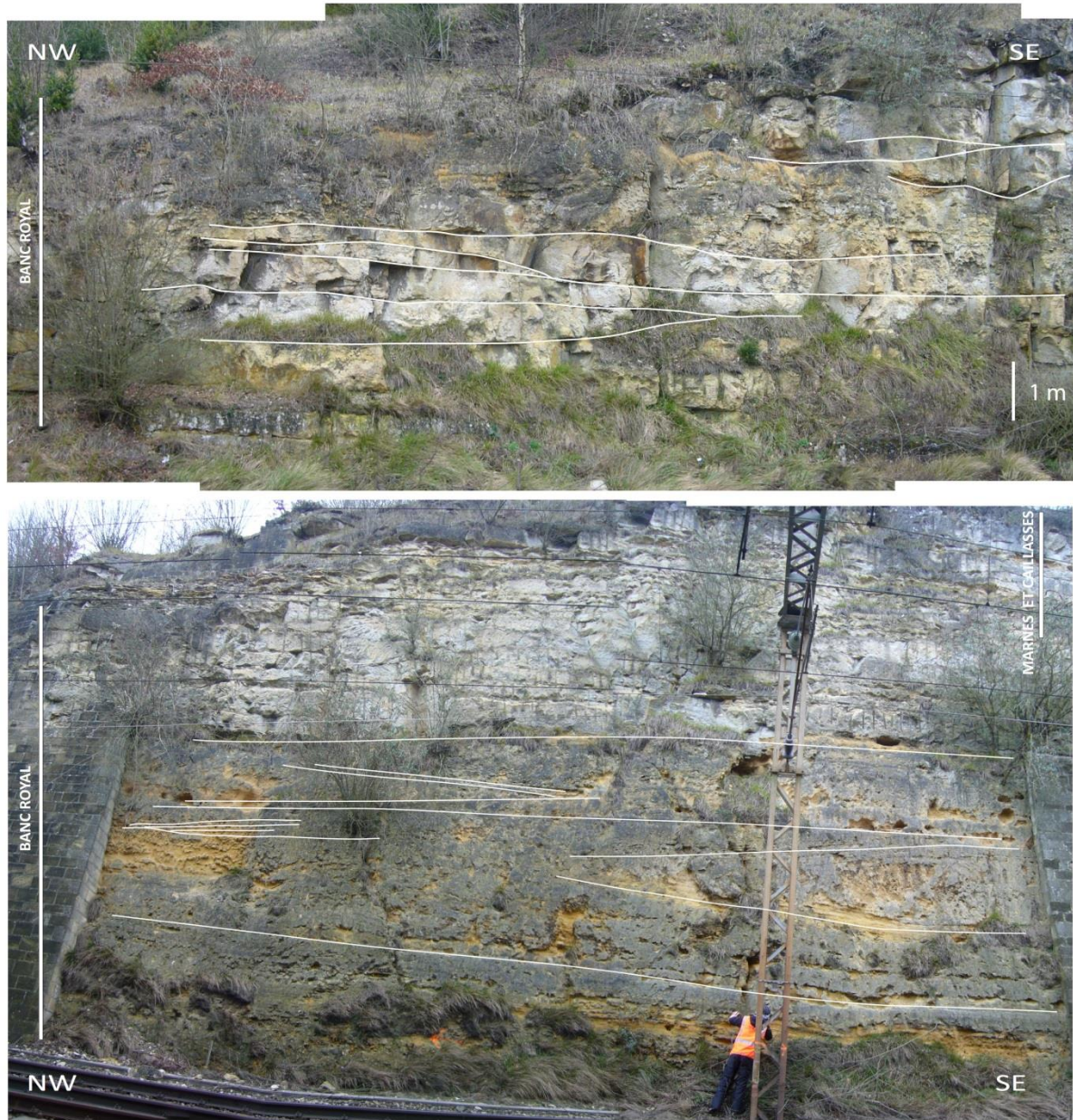
Figure 4.13 : Photos des géométries observées sur la voie ferrée Paris-Creil.
