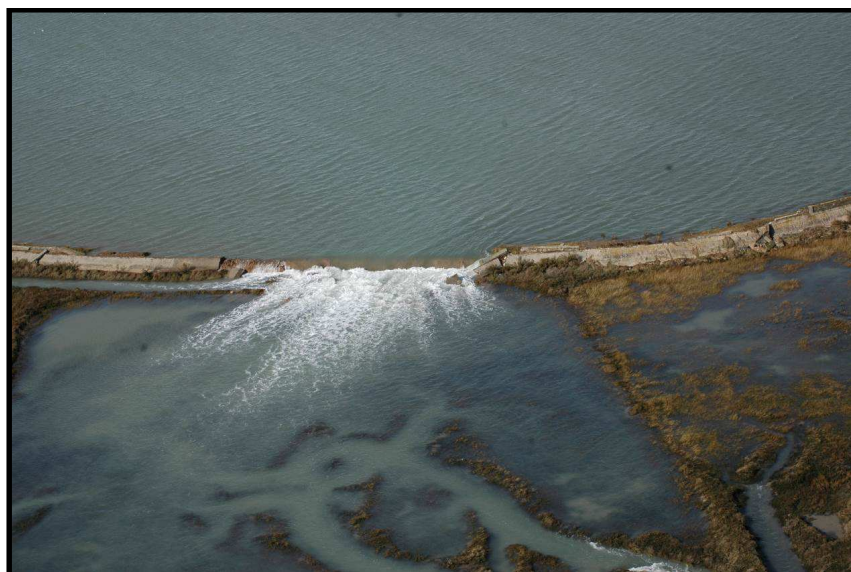
Figure 1.3: Illustration d'une submersion par rupture de digue suite à la tempête Xynthia. Crédit photo : CG17.
