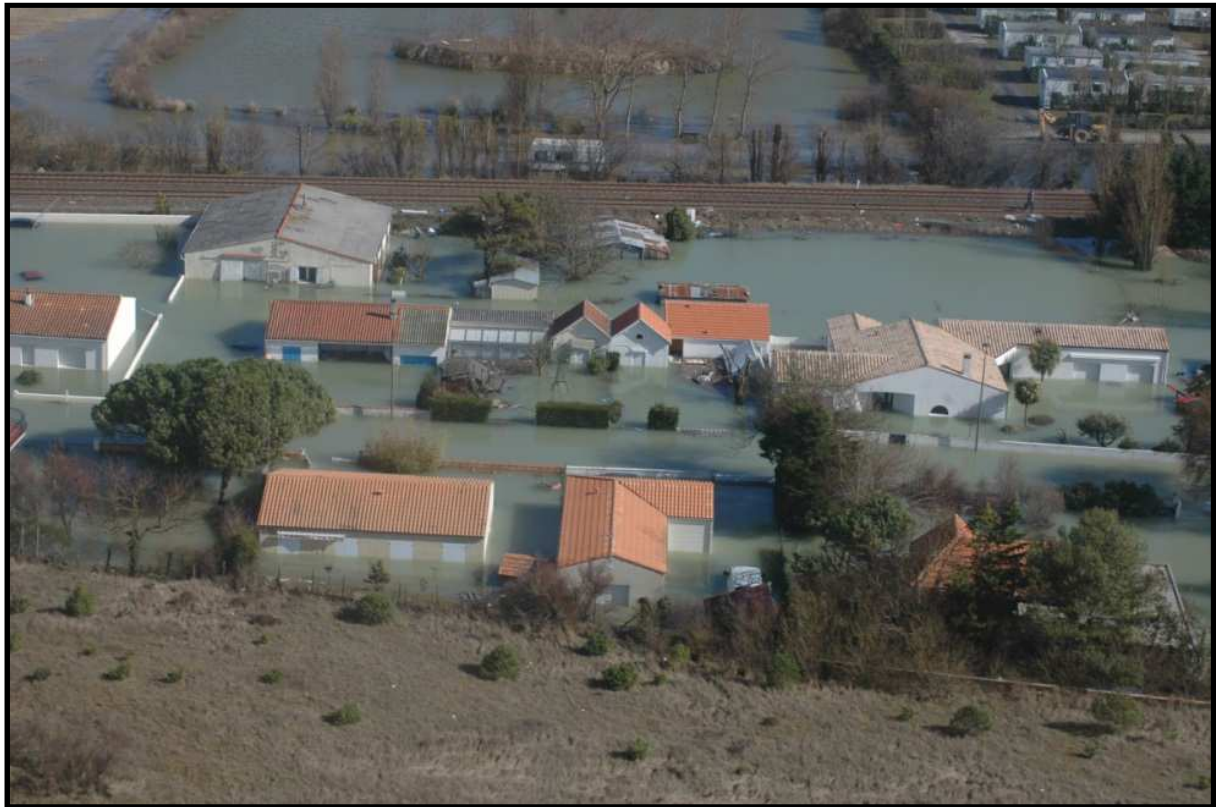
Figure i.3: Exemple de zone urbanisée inondée à Aytré au sud de La Rochelle, suite à la tempête Xynthia en février 2010 (crédit photo : CG17).
