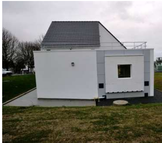
FIGURE III.4 – Photographie de la cellule Ouest
