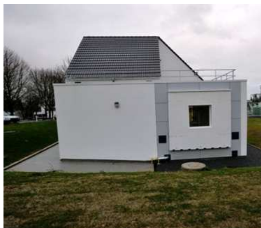
FIGURE III.4 – Photographie de la cellule Ouest
