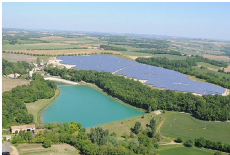
Figure II.28 : Parc solaire de Saint Clar, installé sur 23 ha, puissance de 8,9 MW.
