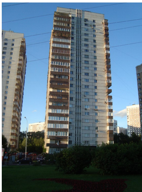
Figure 14 – Photographie de l'immeuble n°17.
