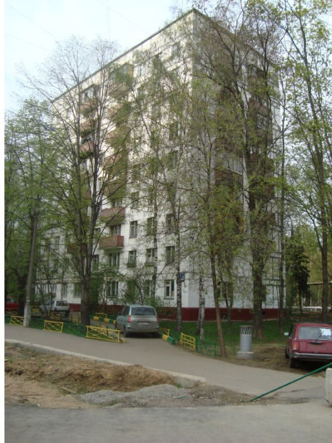
Figure 12 – Photographie de l'immeuble n°13.
