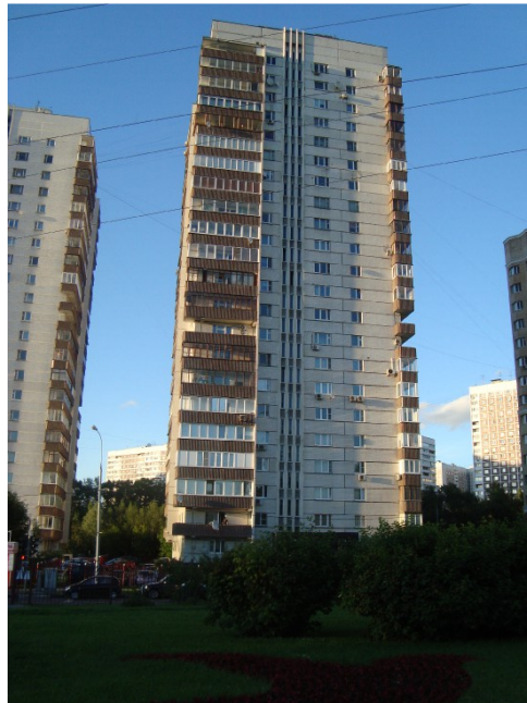
Figure 14 – Photographie de l'immeuble n°17.
