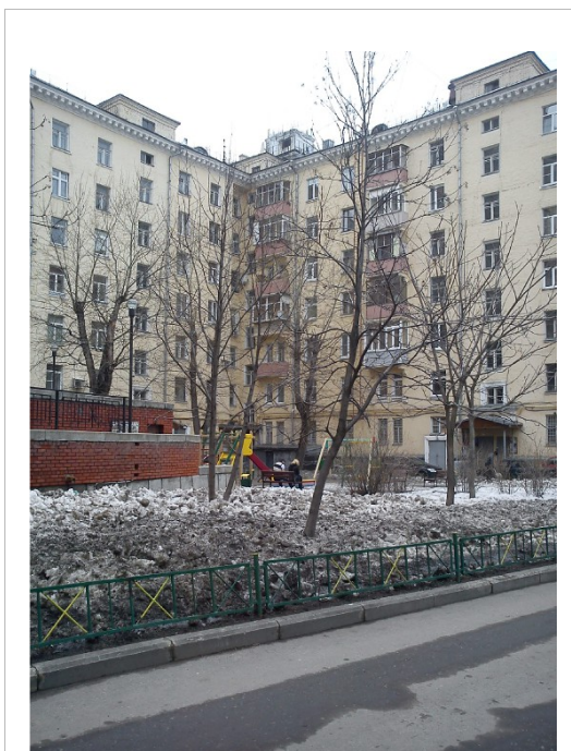
Figure 10 – Photographie de l'immeuble n°1.
