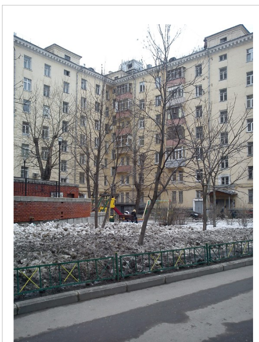
Figure 10 – Photographie de l'immeuble n°1.
