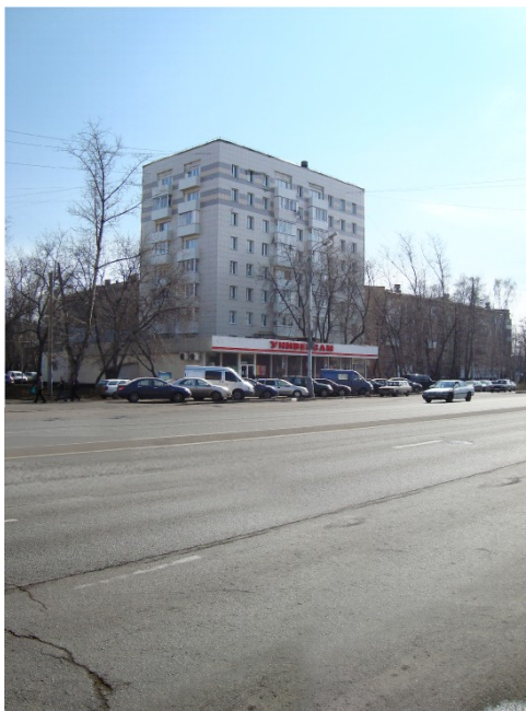
Figure 15 – Photographie de l'immeuble n°22.
