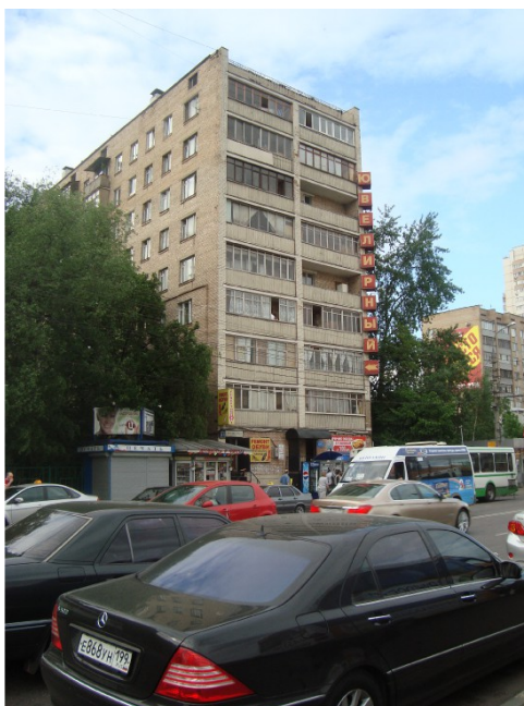
Figure 11 – Photographie de l'immeuble n°7.
