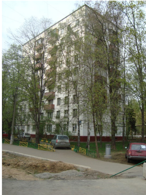
Figure 12 – Photographie de l'immeuble n°13.
