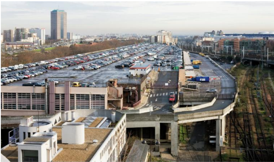
Toit de l'entrepôt Macdonald
