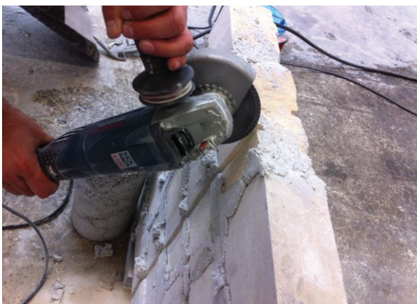
(a) réalisation d'une rainure sur la surface du mur
