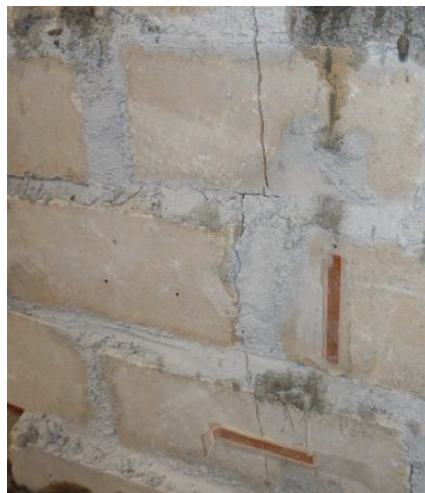
Figure III.11: Compression uni-axiale des murets : mode de rupture par fissuration verticale
