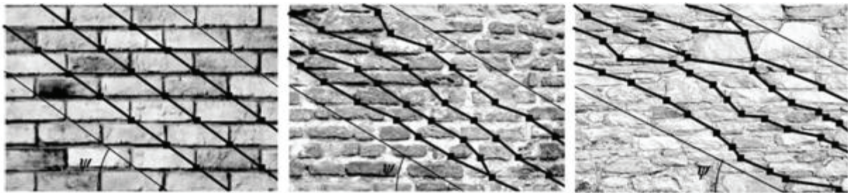
Figure IV.9 : Mesure de l'angle \psi pour le calcul des paramètres de cisaillement global : différentes géométries de mur Calderini et al [140].
