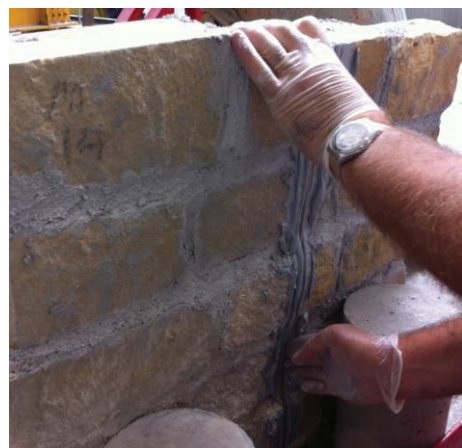
(b) Insertion d'une barre de GFRP dans la rainure
