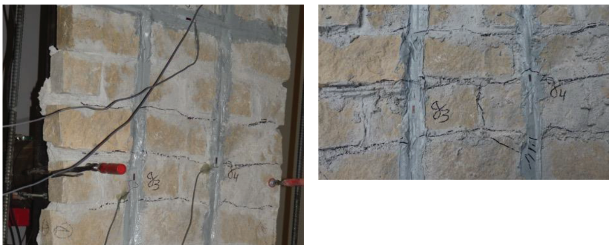
Figure V.12 : Mode de rupture de l'essai de flexion 3 points : M5-NSM-2BV-2BH renforcé par deux barres verticales et deux barres horizontales de GFRP,
