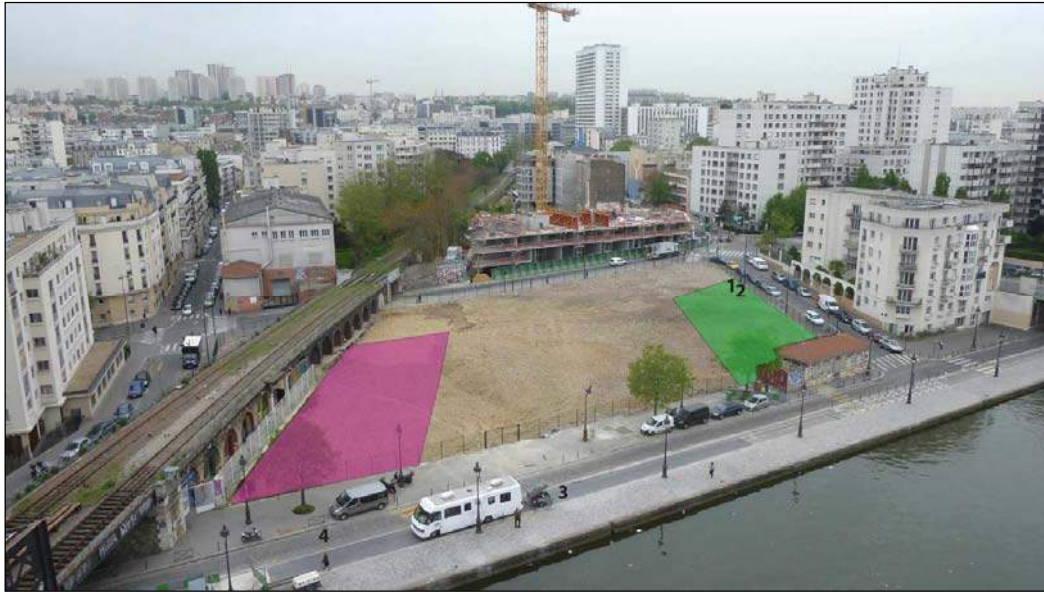
Photographie VII-5 L'emprise de la CPCU après la destruction de l'usine, ancien et nouveau site du vacant jardiné institutionnalisé
