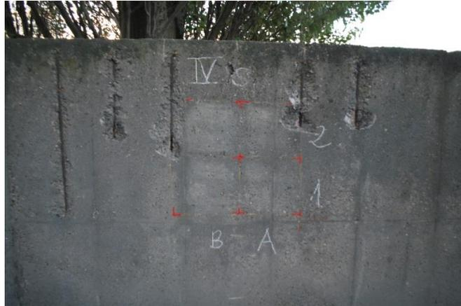
*Fig. 4.33. Photo du mur IV-Sud avec la délamination du béton*
