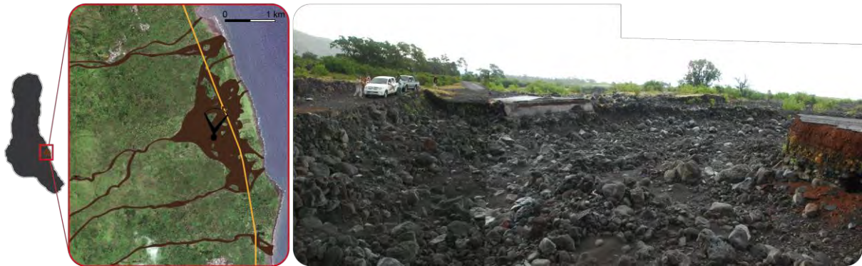
Figure 90 - Route détruite par une coulée de débris sur la côte est de la Grande Comore, au nord de Pidjani et photo-interprétation des lahars sur la zone à partir de Google Earth (clichés J. Morin, avril 2007 ; fonds de carte Google Earth 2009 ; date de l'événement inconnue)
