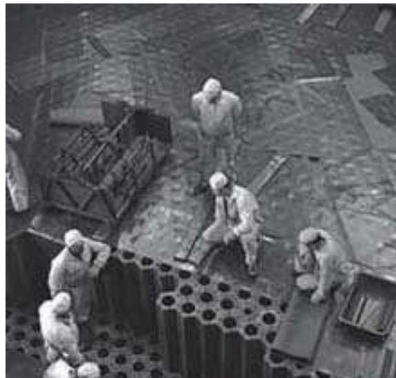
Figure 1 - 9 : Empilement de briques de graphite [EDF].
