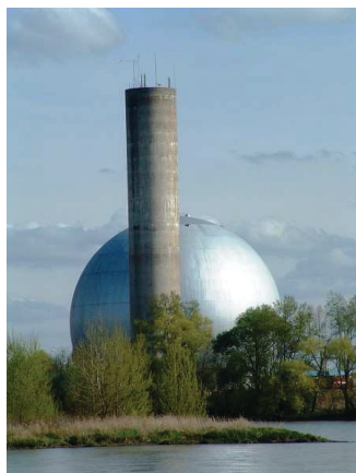
Figure 1 - 1 : Centrale nucléaire de Chinon A1.
