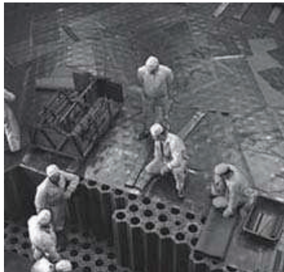
Figure 1 - 9 : Empilement de briques de graphite [EDF].
