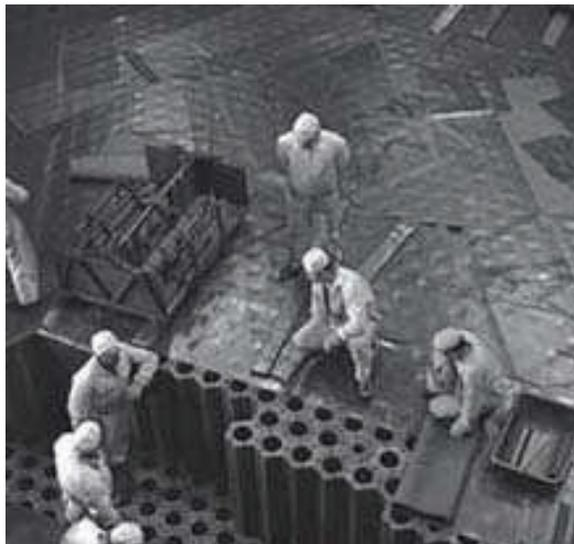
*Figure 1 - 9 : Empilement de briques de graphite [EDF].*
