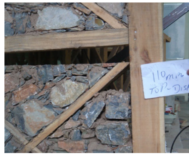
(b) Décrochement du contreventement du cadre principal
