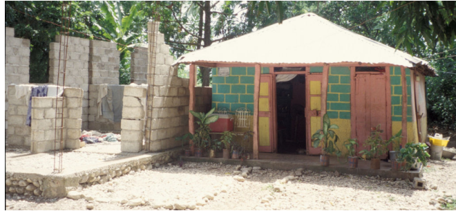
FIGURE 3.14 – Maçonnerie en blocs de ciment
