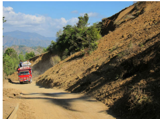
(b) Glissement de terrain le long d’une route
