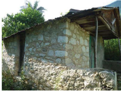
FIGURE 3.13 – maçonnerie de pierre
