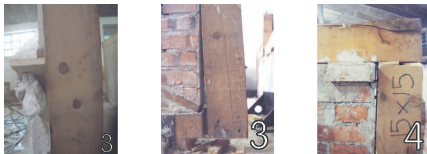
(a) RP : glissement hors-plan du remplissage dû à l'absence de connexion diagonale-cadre
