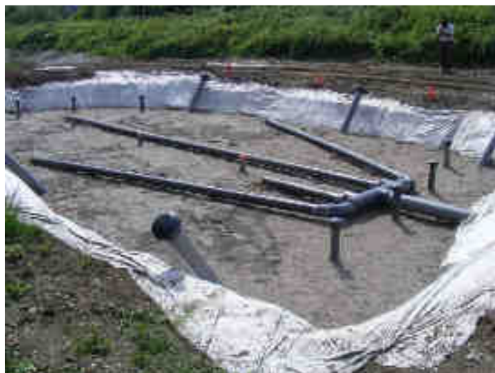
Figure 4-26. Filtre n°1 - Vue des cheminées d'aération de fond et intermédiaire et du dispositif d'alimentation (le 04/07/2012)
