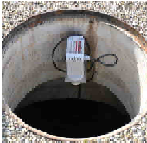
Figure 5-2. Sonde à ultrasons installée sur site
