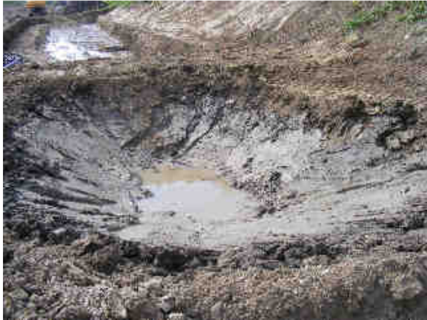
Figure 4-10. Mare de sédimentation n°3 - Mise en place de la couche d'étanchéité en argile (le 17/04/12)
