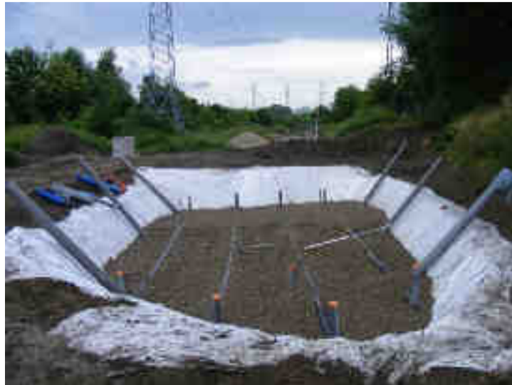
Figure 4-25. Filtre n°1 - Installation de l'aération passive intermédiaire (le 08/06/2012)
