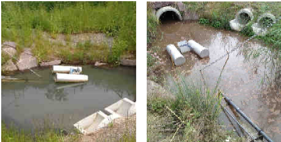
Figure 8-64. Mare de sédimentation n°3 (à gauche, état normal, à droite, état lors du curage du réseau d'assainissement le 27/09/2013)
