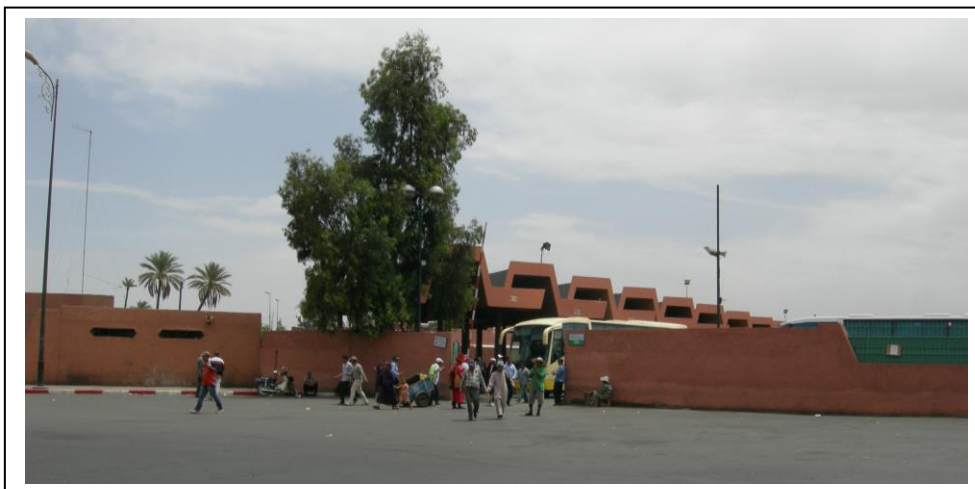
Figure 25. Gare routière de Bab Doukkala à Marrakech. Cliché A. NAKHLI, 2014.
