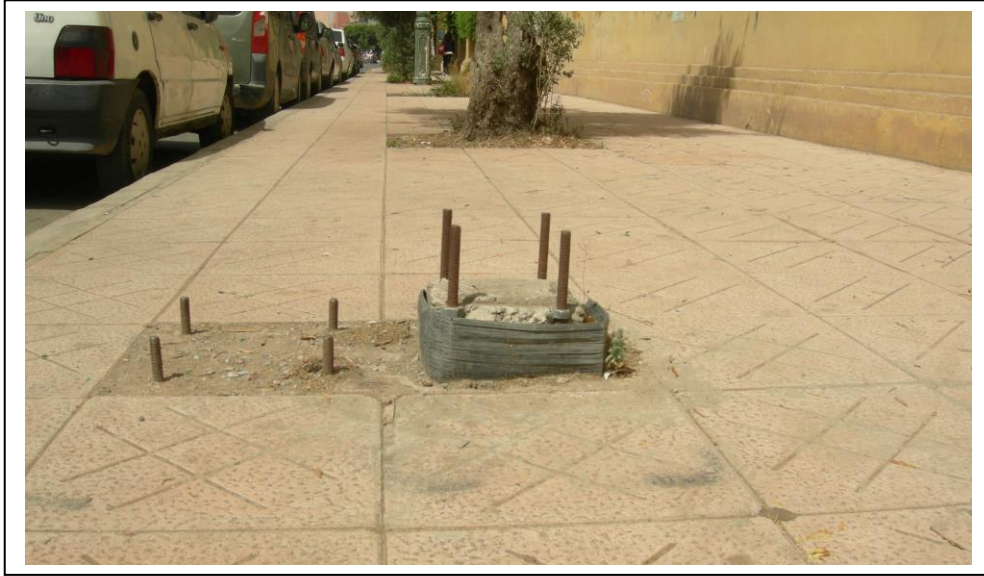
Figure 54. Exemple d'obstacle dangereux sur le trottoir, av. Mohammed VI, Marrakech. Cliché: A. NAKHLI, 2014.
