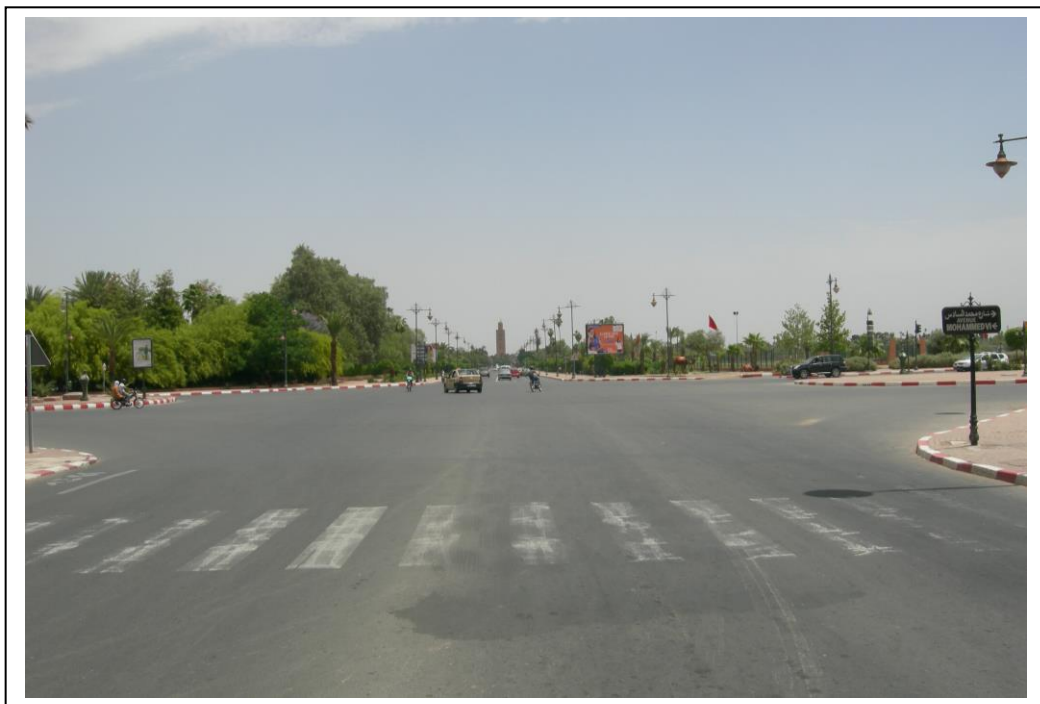
Figure 74. Exemple de passage piéton peu visible, avenue Mohammed VI, Marrakech. Cliché: A. NAKHLI, 2014.
