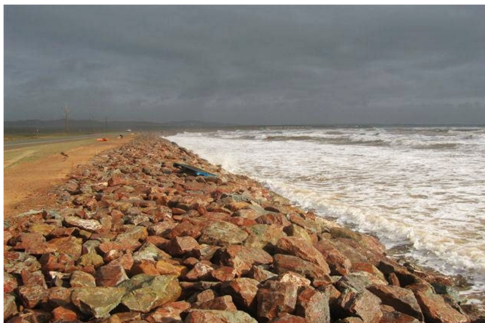
Photo 2 : enrochement, Îles de la Madeleine 18
