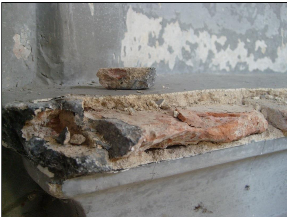
III. 20 Substructure autel latéral droit, 1747-1748, église Saint-Laurent-et-Saint-Barthélémy, Recologne (25) (cliché de l'auteur)
