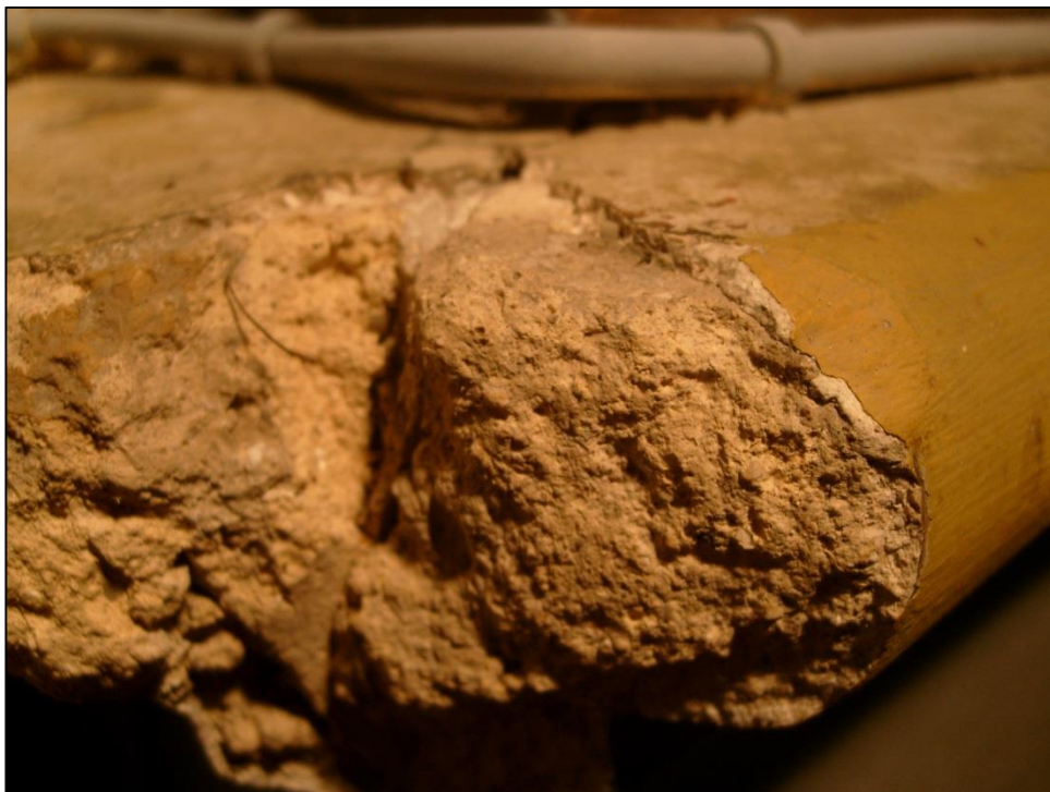
III. 22 Atelier des Marca, détail substructure autel latéral droit, 1766-1767, église Saint-Pierre, Fontain (25) (cliché de l'auteur)
