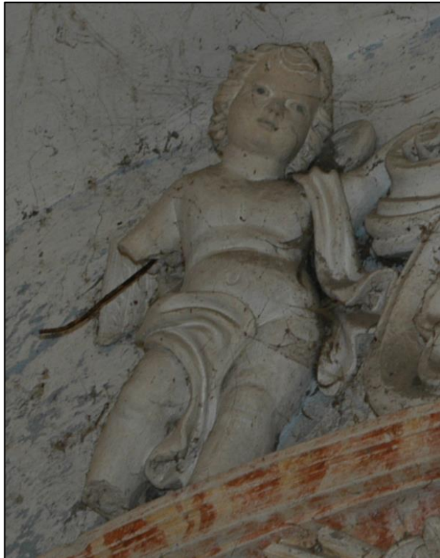
III. 24 Structure métallique d'un angelot, 1755-1756, église du prieuré, Rosey (70) (cliché P. Boisnard)
