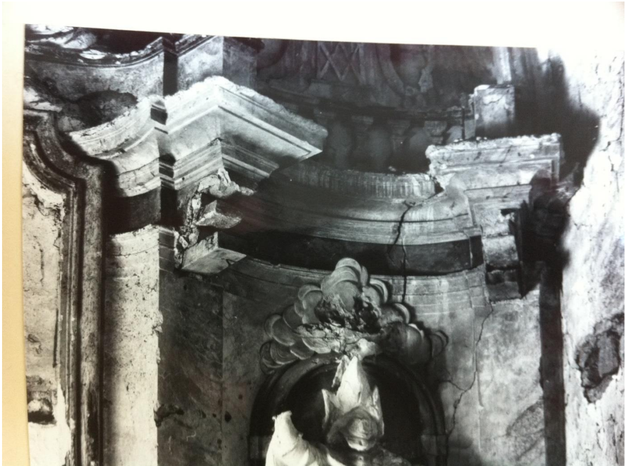
III. 26 Jacques François Marca (attr. à), système d'assemblage des chapiteaux et colonnes du retable majeur, 1754, ancienne église des Annonciades célestes, Champlitte (70) (cliché P. Boisnard)
