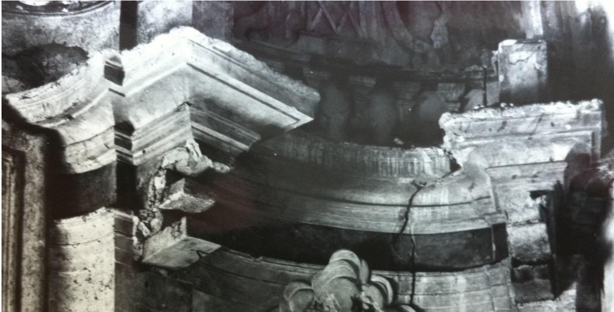
III. 27 Jacques François Marca (attr. à), système d'assemblage des chapiteaux et colonnes du retable majeur (détail), 1754, ancienne église des Annonciades célestes, Champlitte (70) (cliché P. Boisnard)
