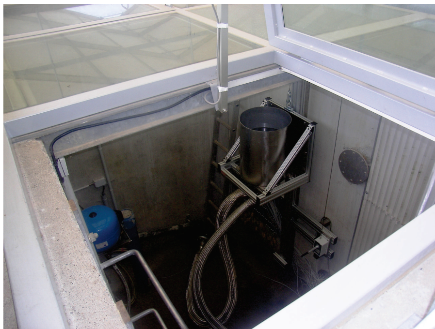
FIGURE 4.8 – Photo de la fosse amont sur le bassin SCERES
