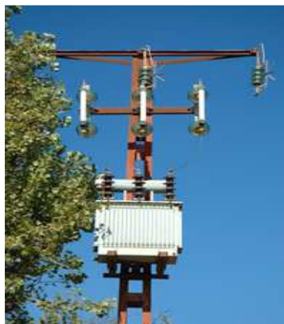
Figure 1.7 : Poste de distribution HTA/BTA type « poteau ».
