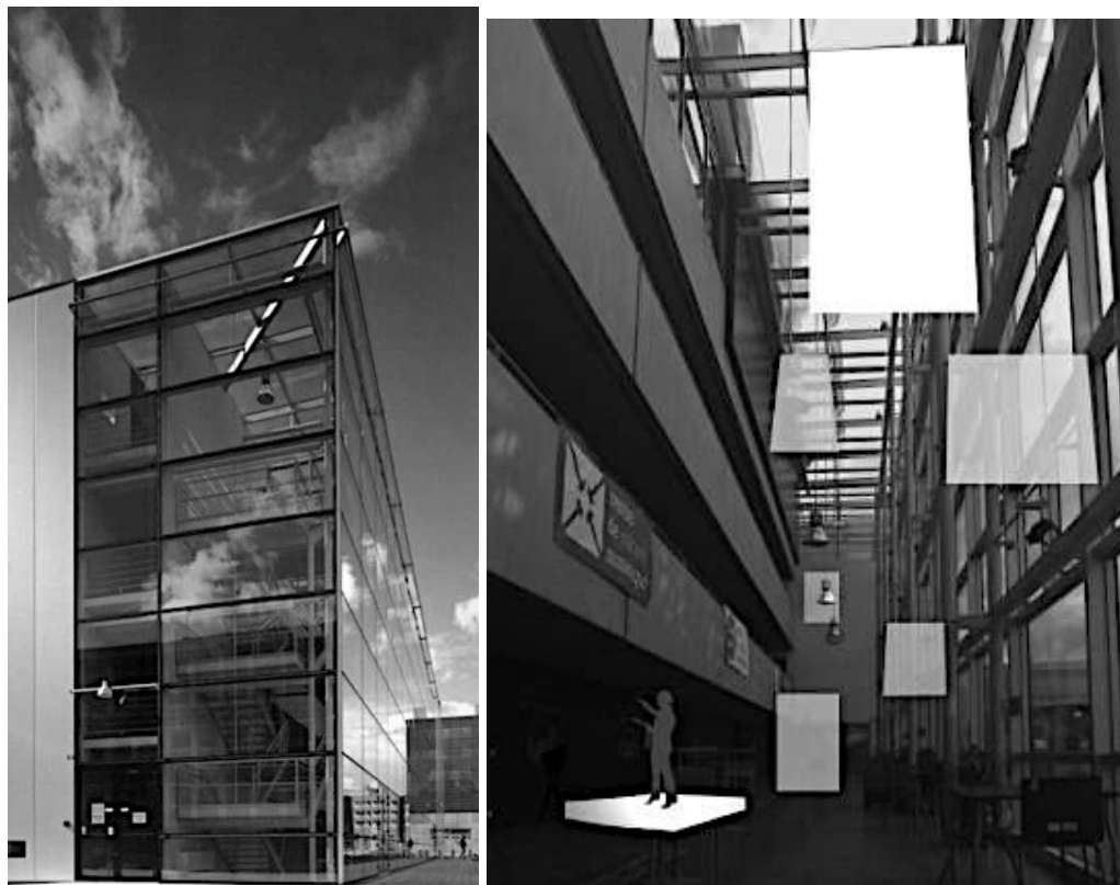
Figure 283 73. À gauche (a), la vue extérieure du bâtiment Atrium. À droite (b), la vue intérieure du bâtiment, avec une proposition en maquette de possibles installations 284 .
