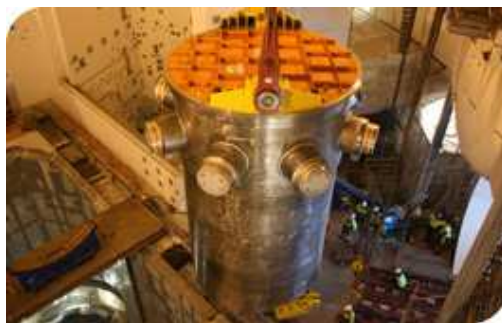
FIGURE 4.1 – Cuve d'un réacteur [65]
