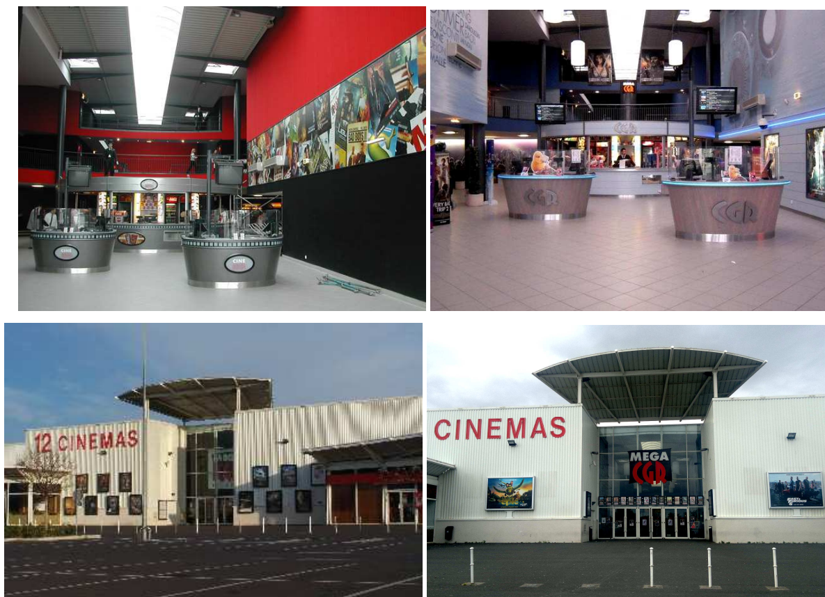
Figure 46. Cinéma CGR : Travaux de modernisation
