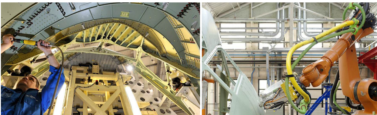
Figure 1.8 – Opérations d'assemblage et de perçage (images Aerolia).
