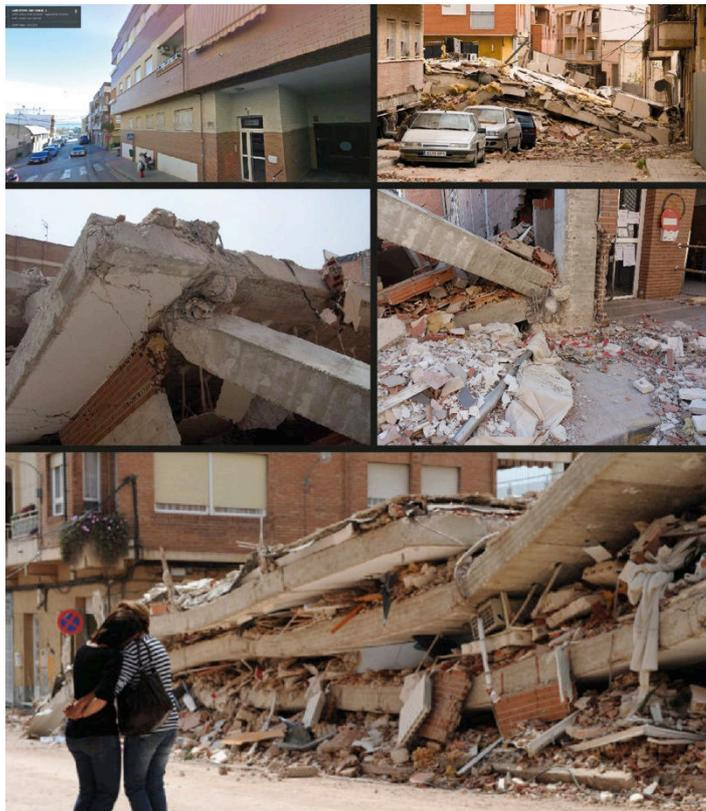
Figure 30. Images du seul bâtiment que s'est effondré. En haut à gauche, une image extraite de Google Maps montre le bâtiment avant le séisme ; les autres montrent les dégâts après la secousse. Sources : *Libertad digital, la Vanguardia, Itesia*.
