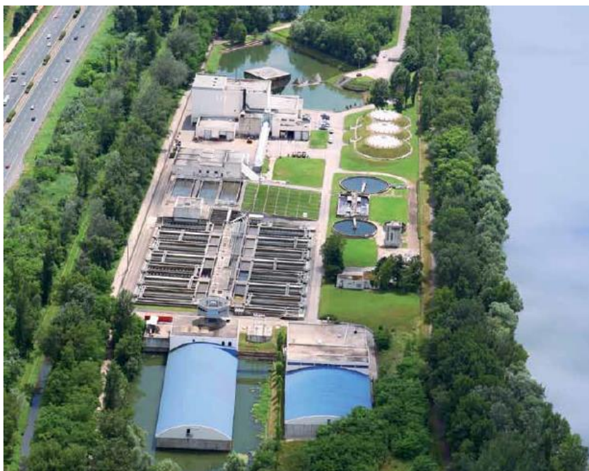
Figure 2-13 : Station d'épuration d'Aquapôle vue du ciel [Métro, 2011]
