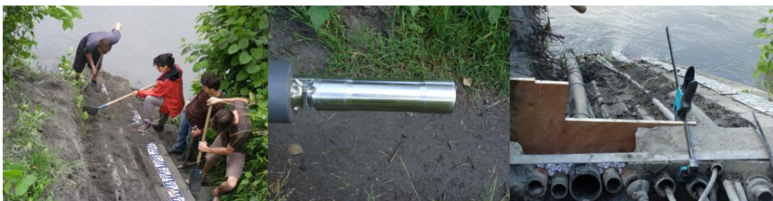
Figure 3-8 : Photographies prises lors de l'installation de la sonde à la station campus (juin 2011)
