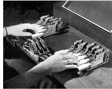
FIGURE 1.11 – Le contrôleur du Voder, d'après [DRW39].
