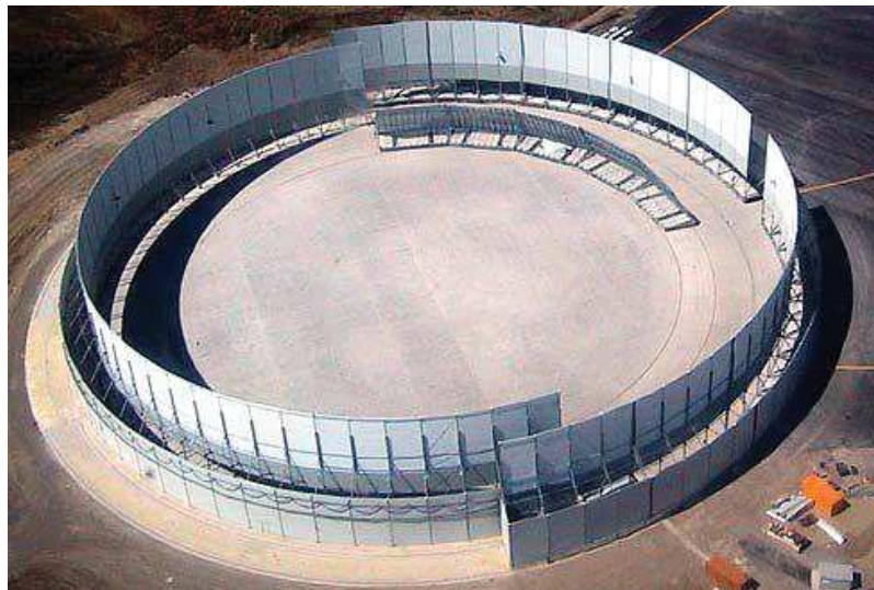
L'aire de point fixe d'AéroConstellation (source : revue Travaux : 2005).
