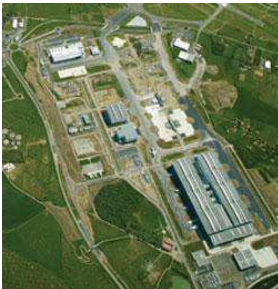
Vue aérienne de la Zac Aéro-Constellation (Source : grandtoulouse.org)
